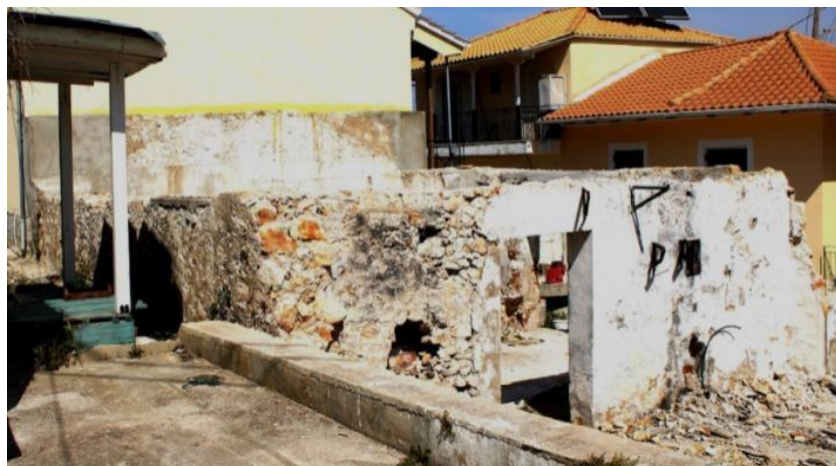
Εικόνα 2&3: Υφιστάμενη κατάσταση κτιρίου.
